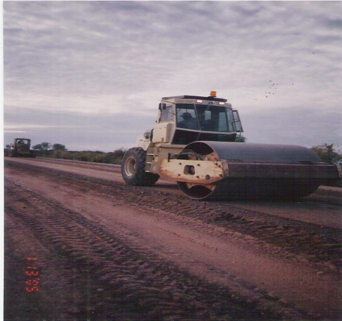
Fig. 2.8.5. Compactación con rodillo metálico vibratorio
