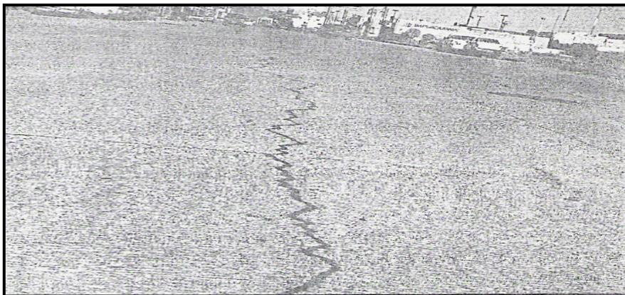
Fig. 1.1.1. Fallas en la obra de la calle Guerrero debido a la expansión de las arcillas.
