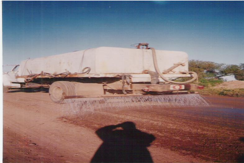
Fig. 2.8.3. Riego ligero a todo lo ancho del camino para mejor homogenización.
