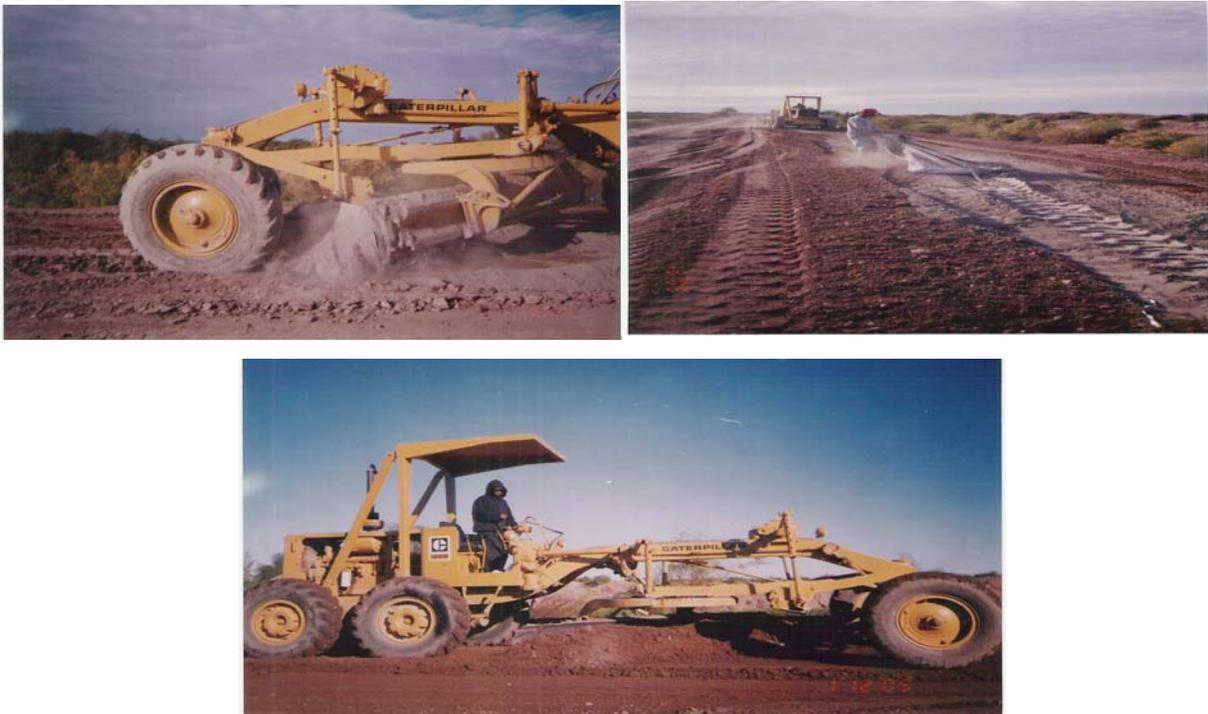
Fig. 2.8.2. Rompimiento de los sacos de cemento mediante Motoconformadora, retiro de los sacos, y por último homogenización de suelo-cemento en húmedo.
