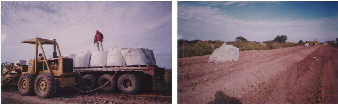
Fig. 2.8.4. Jalón de los sacos de cemento por medio de la Motoconformadora y colocación de los sacos a distancia ya establecidas.
