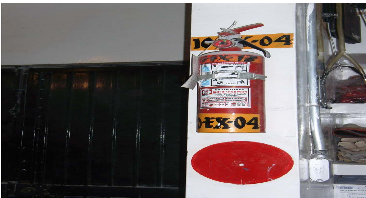
Figura 23. Equipo de Seguridad Bien Ubicado con Señalización.
