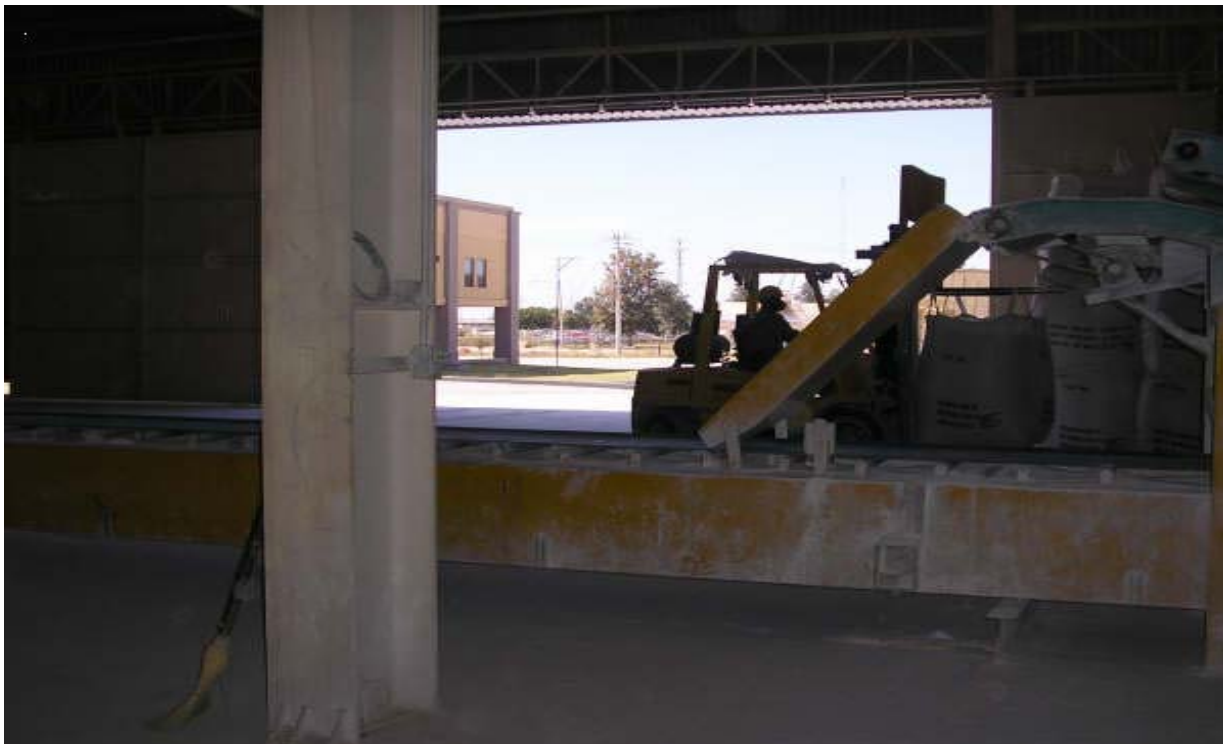
Figura 4. Área de Texturizado Bandas de Transporte. Fuente: Elaboración Propia.
