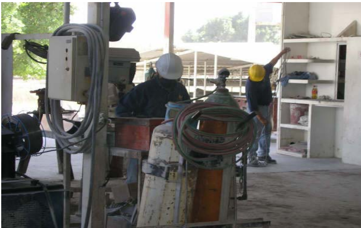
Figura 9. Área de Mantenimiento. Fuente: Fuente: Elaboración Propia.
