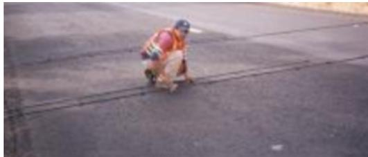
Figura III.2 (Colocación de Tubos transversalmente en la calzada para llevar a cabo el conteo vehicular.)
