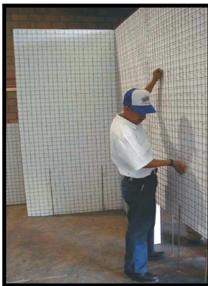
*Figura 2.6.-Ensamble de hoja de tridipanel en anclas.*
