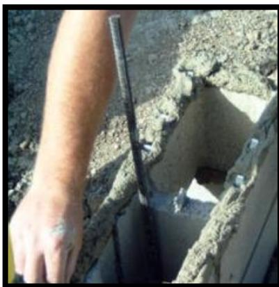
*Figura 2.2-*. Colocación de mortero para pegado de Block.
