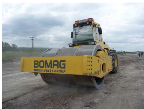
Figura II.2 Compactación mecánica del suelo
