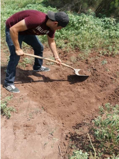
Figura III.4 Limpia y nivelación del lugar.
