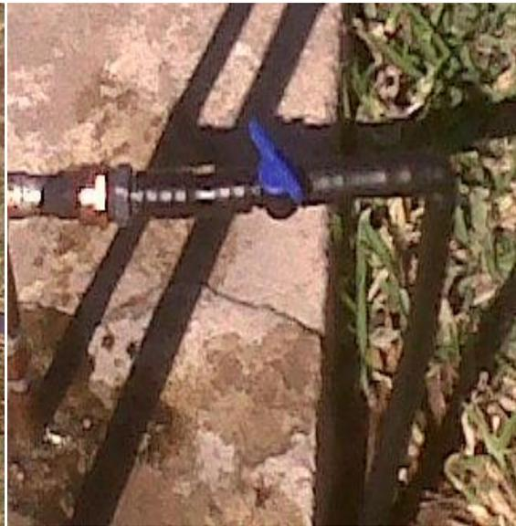
Figura 13. Conexión llave de paso
