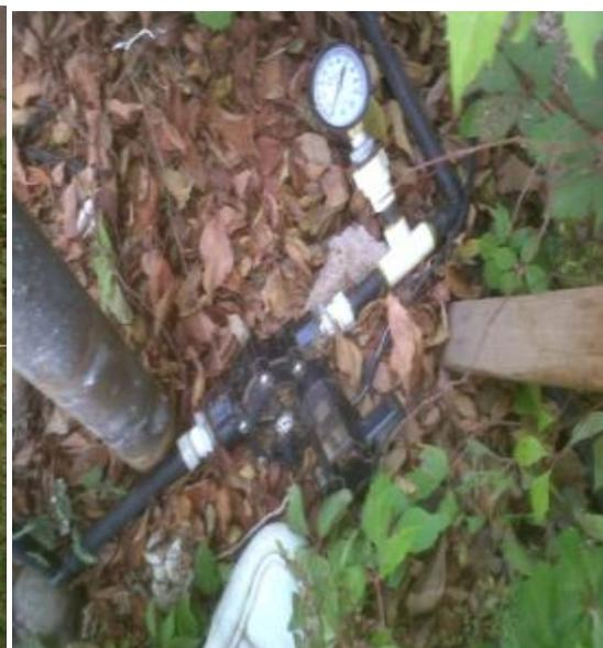
Figura 15. Conexión de válvula eléctrica
