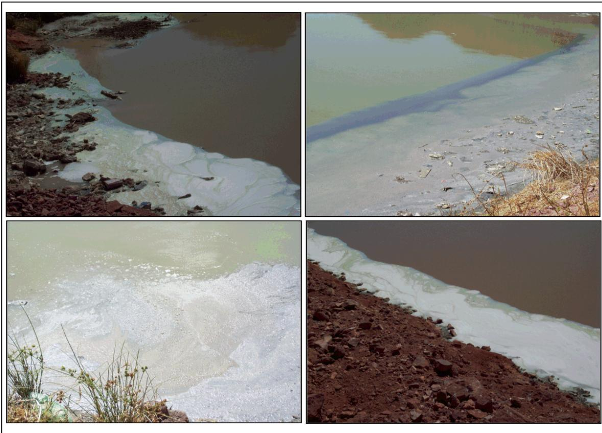
Figura No 3. Depósitos de aceite vegetal en la Laguna de Oxidación en Guaymas.
