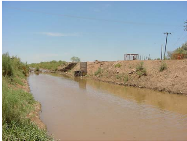
Foto 6.- Colector principal No. 1
