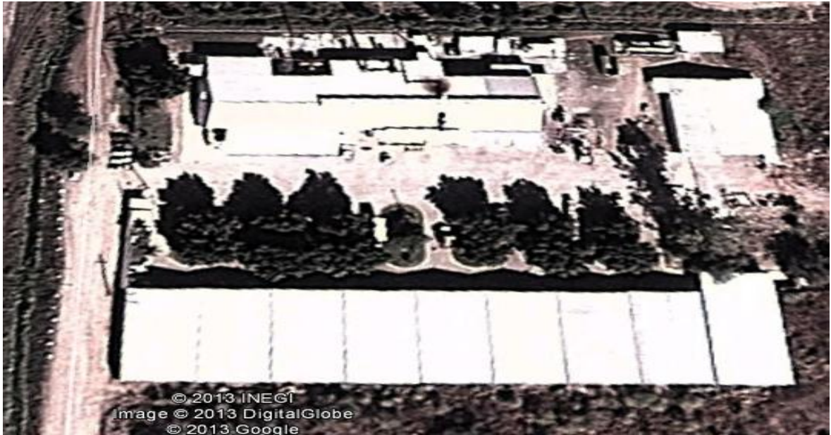
Figura 9. Instalaciones de CEMOPAC.
