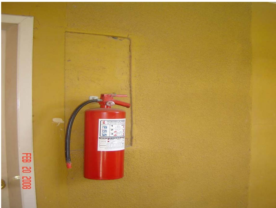
Figura14. Falta de señalización.
