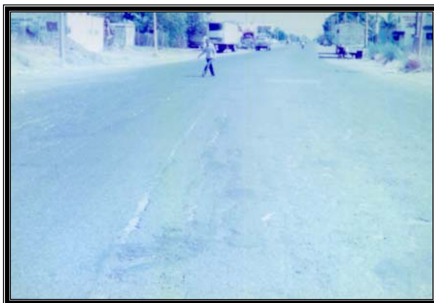
Figura 4-3. Fallas tipo surco.
