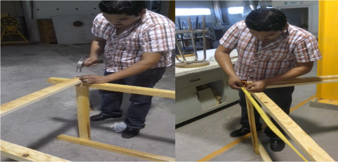
Figura 16. Unión de los dos marcos con fajillas las fajillas.
