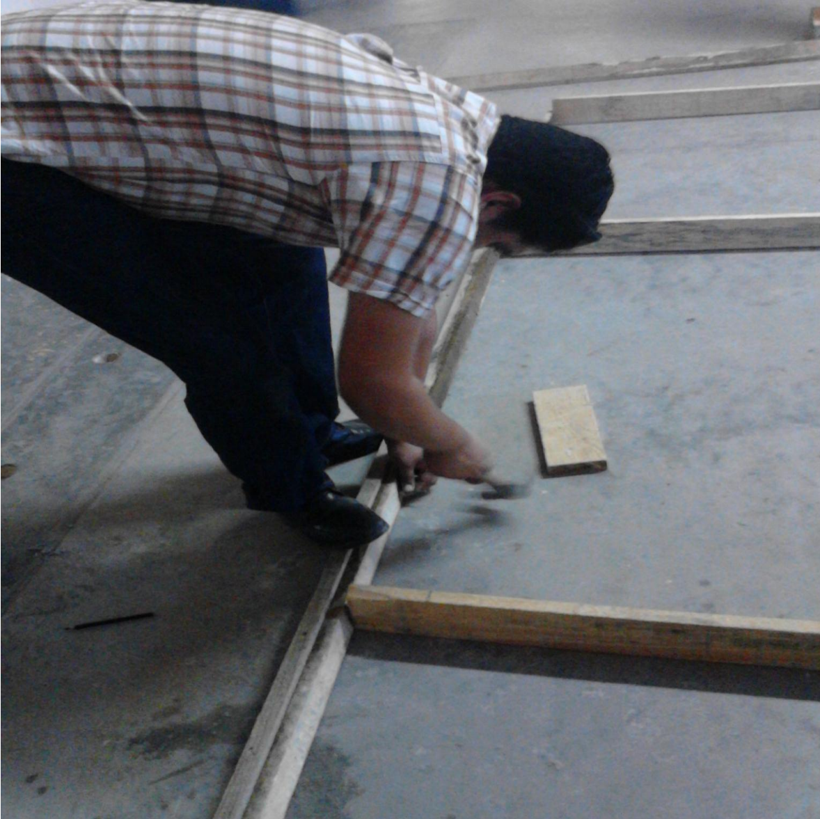
Figura 6. Armado de cimbra.
