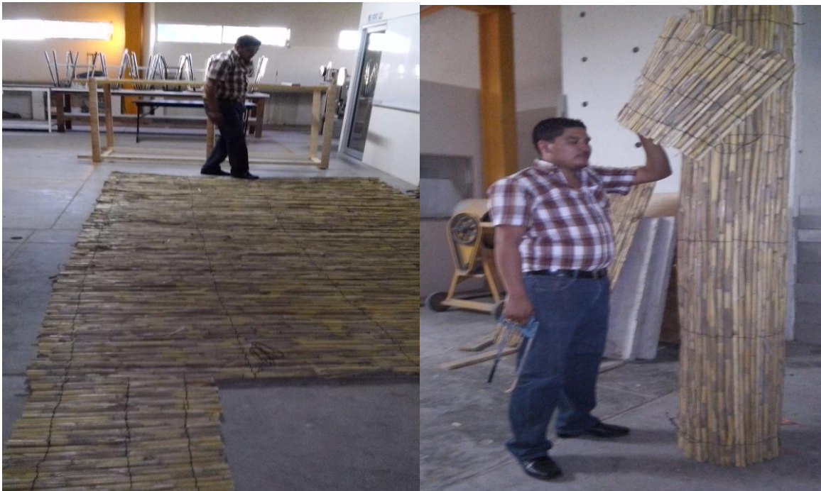
Figura 18. Malla de carrizo entreverado para los muros.
