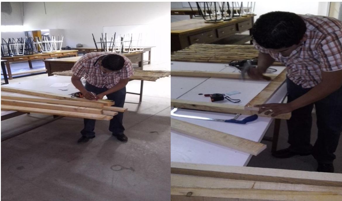
Figura 14. Marcado y uniones de las tablas con clavos de acero.
