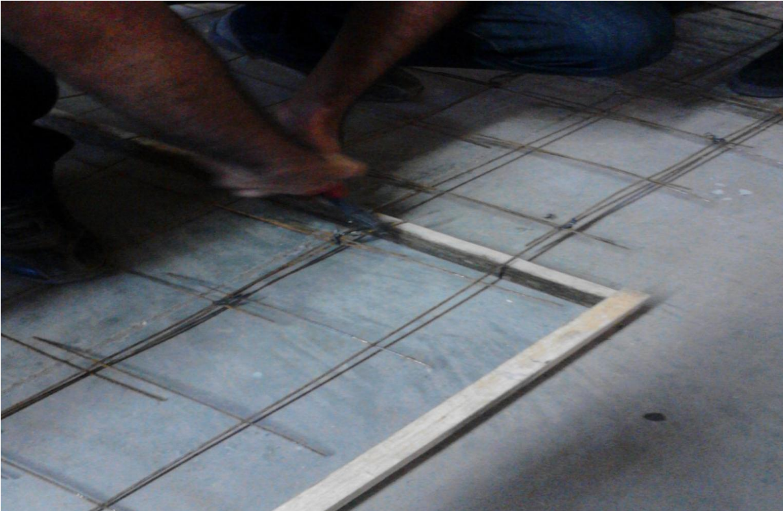
Figura 7. Colocación y cortado de malla 15 x15 cm.
