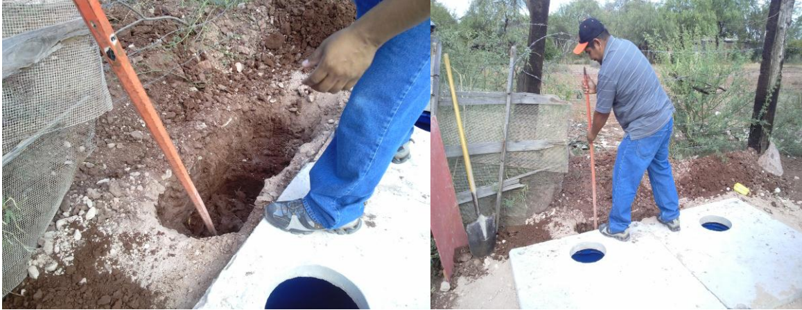
Figura 22. Excavación para contenedores de sólidos.
