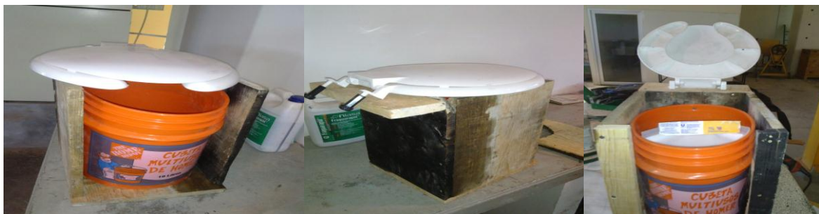
Figura 23. Construcción de tasa del baño.
