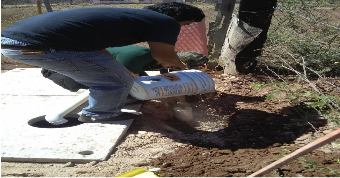
Figura 21. Acarreo y relleno de material en excavación.
