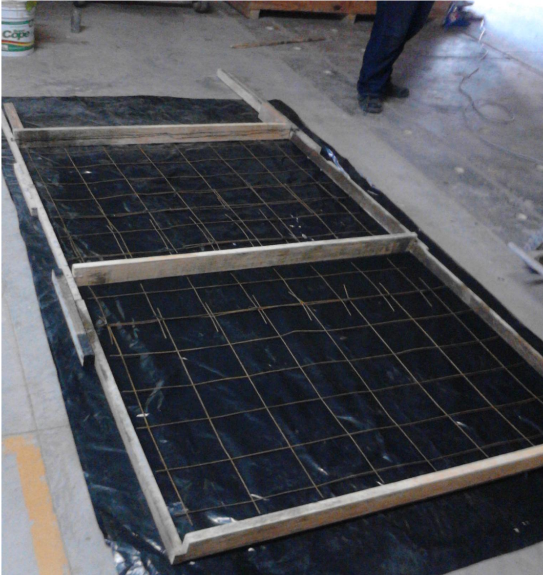
Figura 8. Hule negro debajo de la cimbra y el acero.
