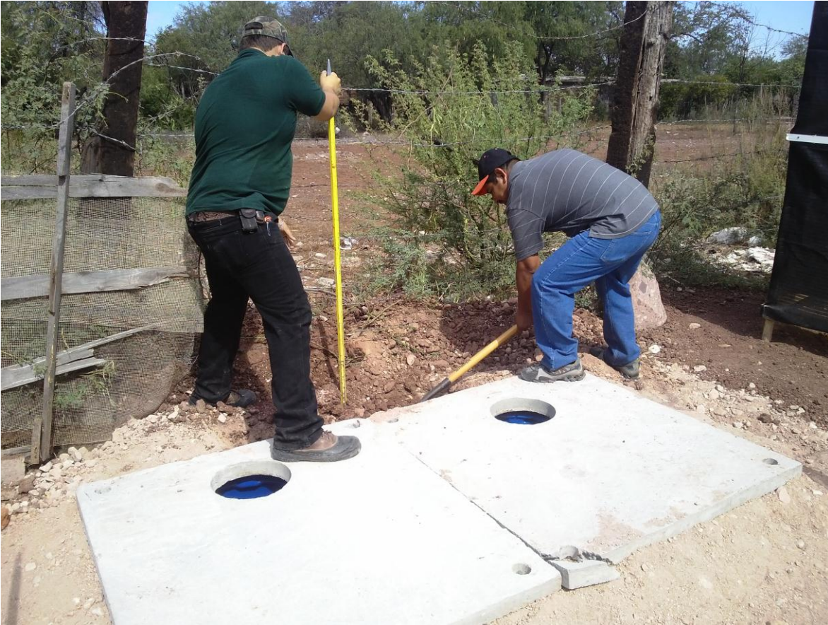
Figura 20. Despalme del sitio de construcción.
