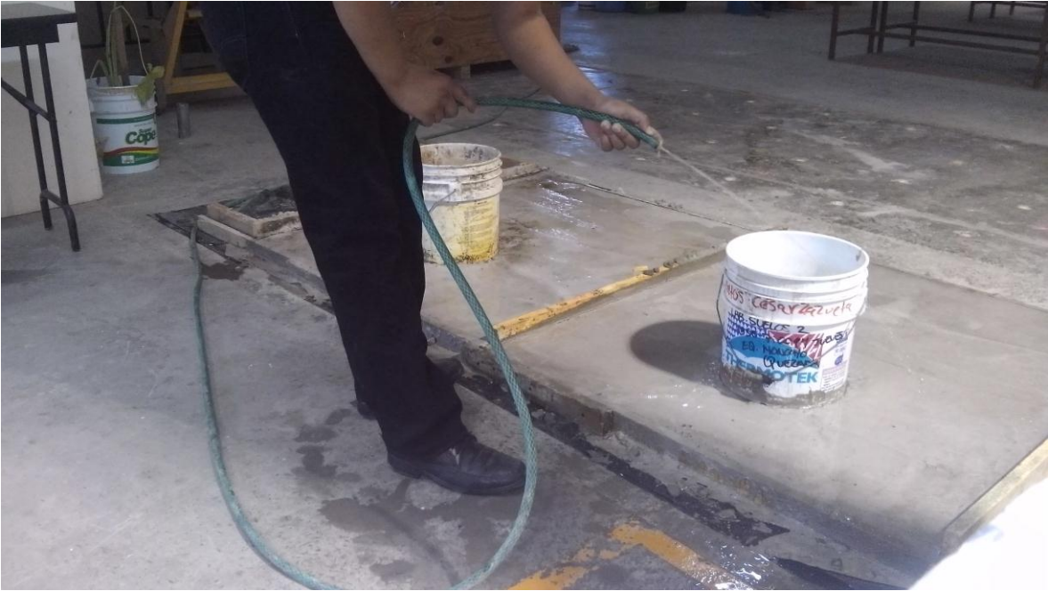
Figura 12. Humedecimiento de losas en el fraguado.
