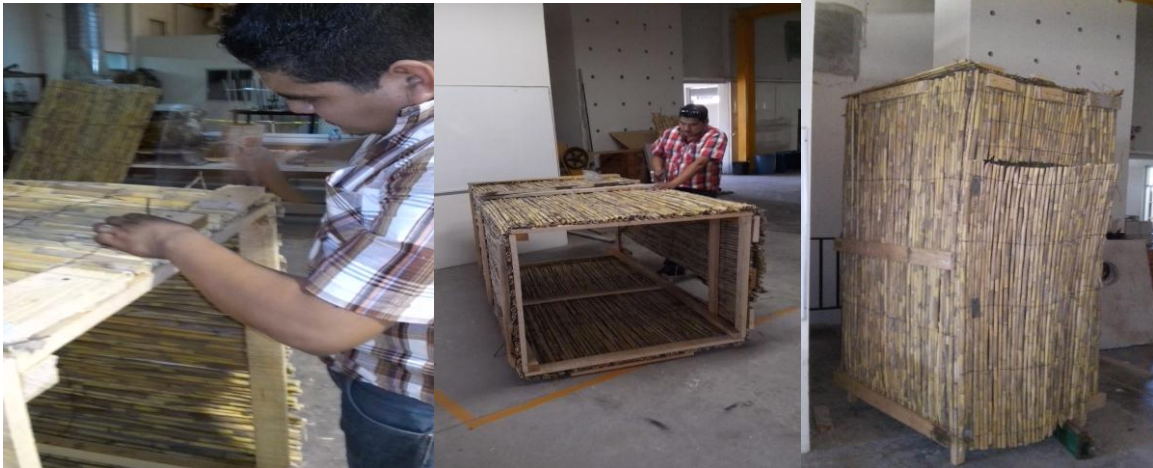
Figura 19. Unión de los muros a la estructura.
