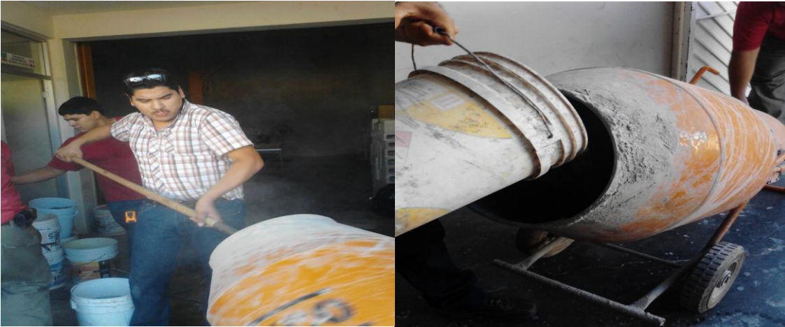
Figura 9. Elaboración del concreto.
