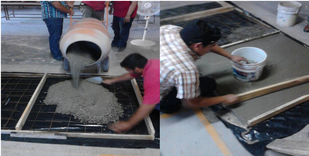
Figura 11. Elaboración de la losa.
