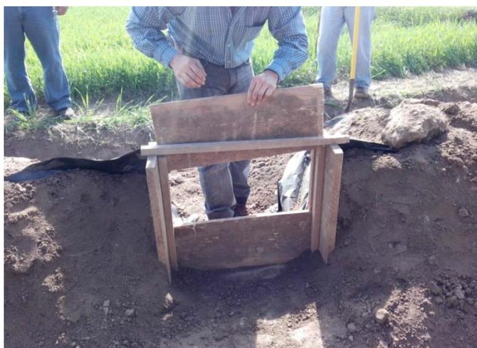
Figura 5. *Instalación de compuerta.*
